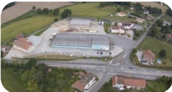
Centre d'allotement à St-Juste-le-Martel en Haute-Vienne Crédits : GLBV
