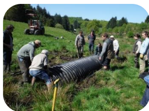
Mise en place d'un canal pour restaurer l'écoulement d'un ruisseau
