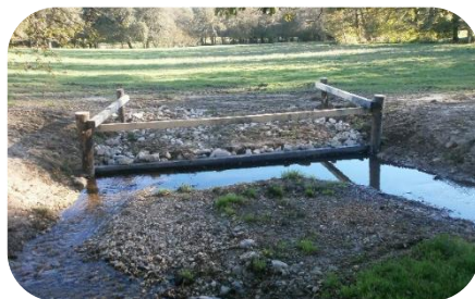
Abreuvoir en descente aménagée sur le ruisseau des Vergnes, affluent du Thaurion.
