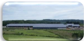
Atelier de la Courtine situé sur un terrain militaire réhabilité.
